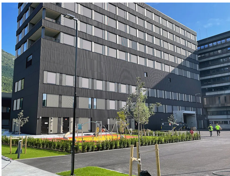
Livabygget ved Førde sentralsjukehus opna tysdag 20. august 2024.
