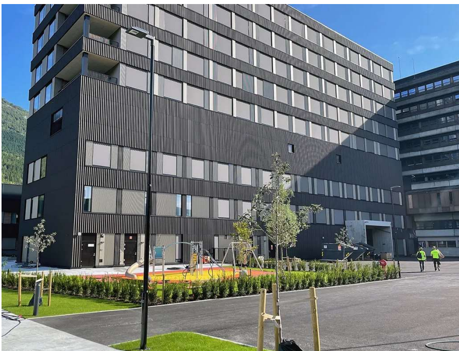
Livabygget ved Førde sentralsjukehus opna tysdag 20. august 2024.
